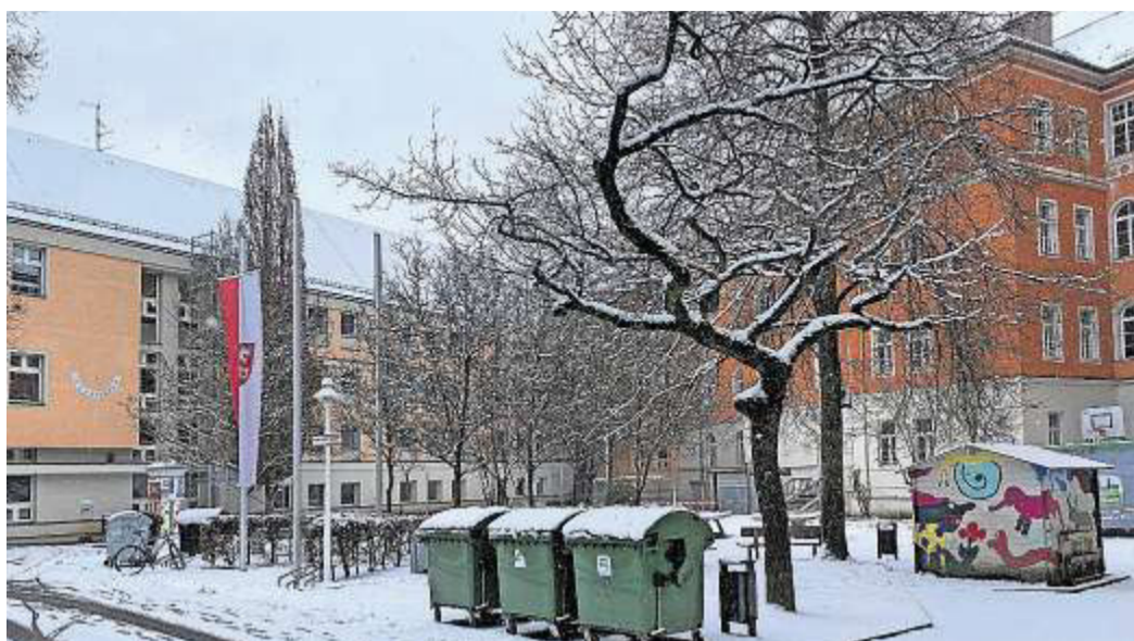
Die leerstehende Kreuzschule (li.) muss ertüchtigt werden, um wie geplant die Raumnot der Realschule am Judenstein (re.) lindern zu können. Foto: Jonathan Ederer
